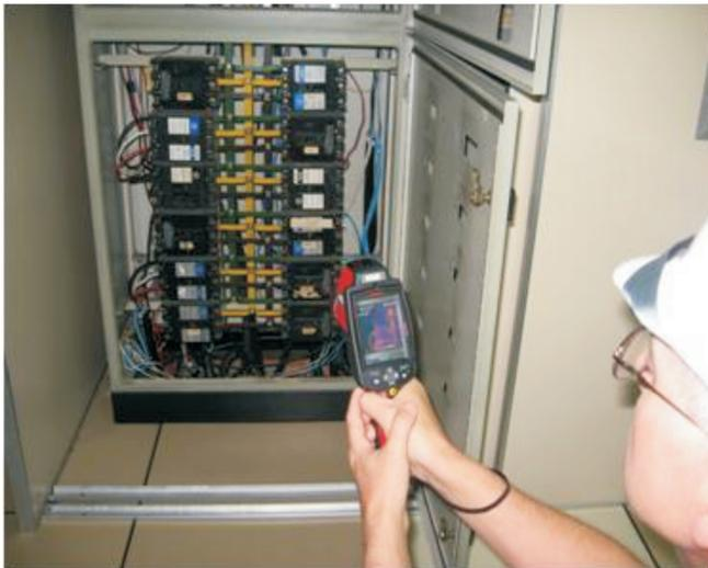
Figura 1 - Técnico analisando termograficamente instalações elétricas
