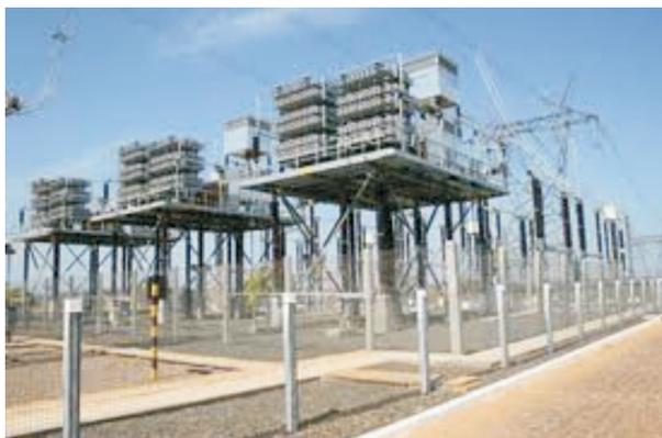
Figura 4 – Banco de capacitores em funcionamento
