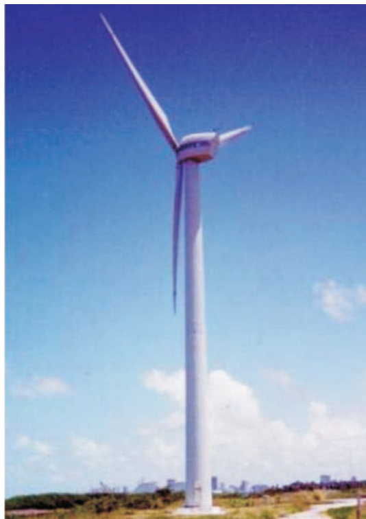
Figura 14 – Central eólica de Olinda - PE
