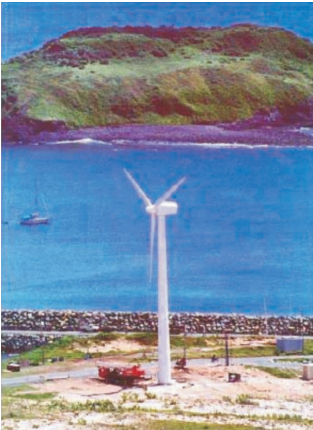
Figura 8 – Segunda turbina eólica de Fernando de Noronha-PE
