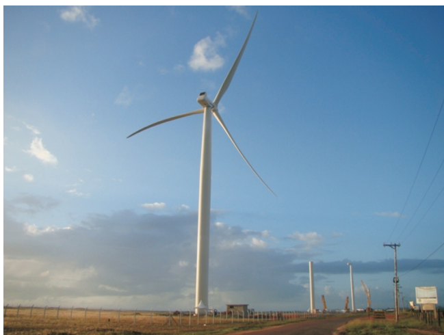
Figura 1 - Usina eólica em fase de implantação no município de São Francisco de Itabapoana (RJ)
