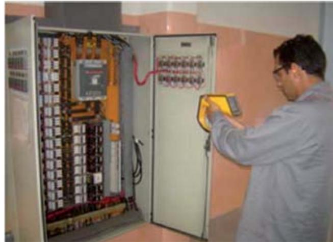
Figura 1 - Inspeção termográfica no sistema elétrico para detecção de pontos de aquecimento
