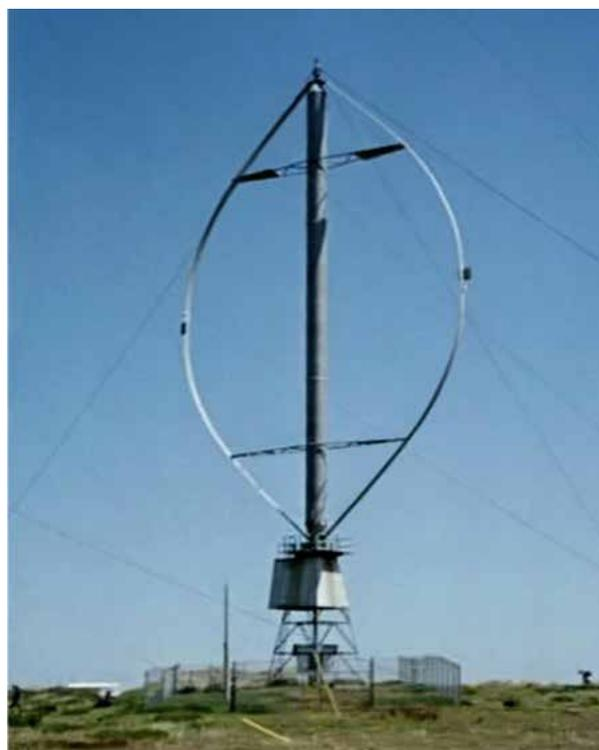
Figura 4 – Aerogerador de eixo vertical tipo Darrieus
