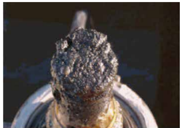
Figura 5 - Resíduo e condensado sobre cupom de corrosão retirado do duto X Fonte: da Nóbrega et al., 2012
