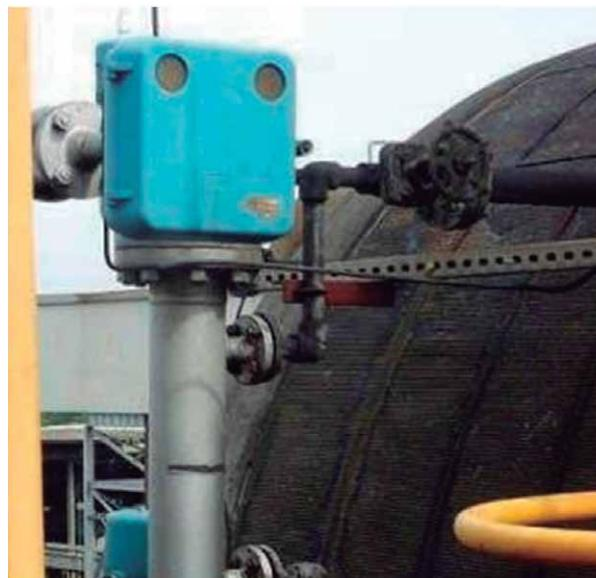
Figura 2 – Transmissor (medidor) de nível por empuxo
