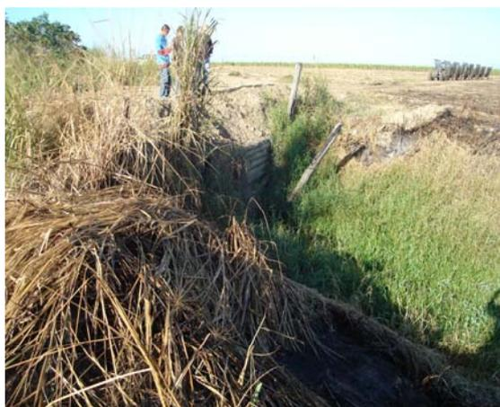
**Figura 3: Estrutura de manilha com diâmetro inferior ao recomendável**
