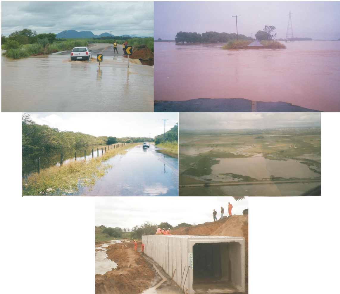
Figura 8 - 1- Ultrapassagem das águas do Rio Muriaé sobre a BR-356 (2009). 2- Queda de trecho da RJ-194 por pressão do Rio Paraíba do Sul (2007). 3- Transbordamento do curso original do Rio Guaxindiba na RJ-196, em janeiro de 2007, por falta de sistema adequado de circulação sob a rodovia. 4- Estrada dos Ceramistas pressionada pelas águas da cheia de 2008-2009. 5- Reforma do sistema de drenagem da RJ-224 com bueiros celulares de 2x2 m.
