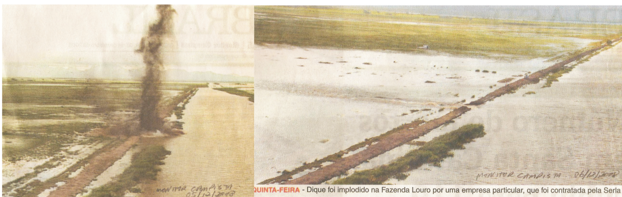
Figura 4 - Detonação de um dique invasor da Lagoa Feia (E). Água da Lagoa ocupando parte de seu antigo leito depois da explosão. Fotos de jornal (2008).
