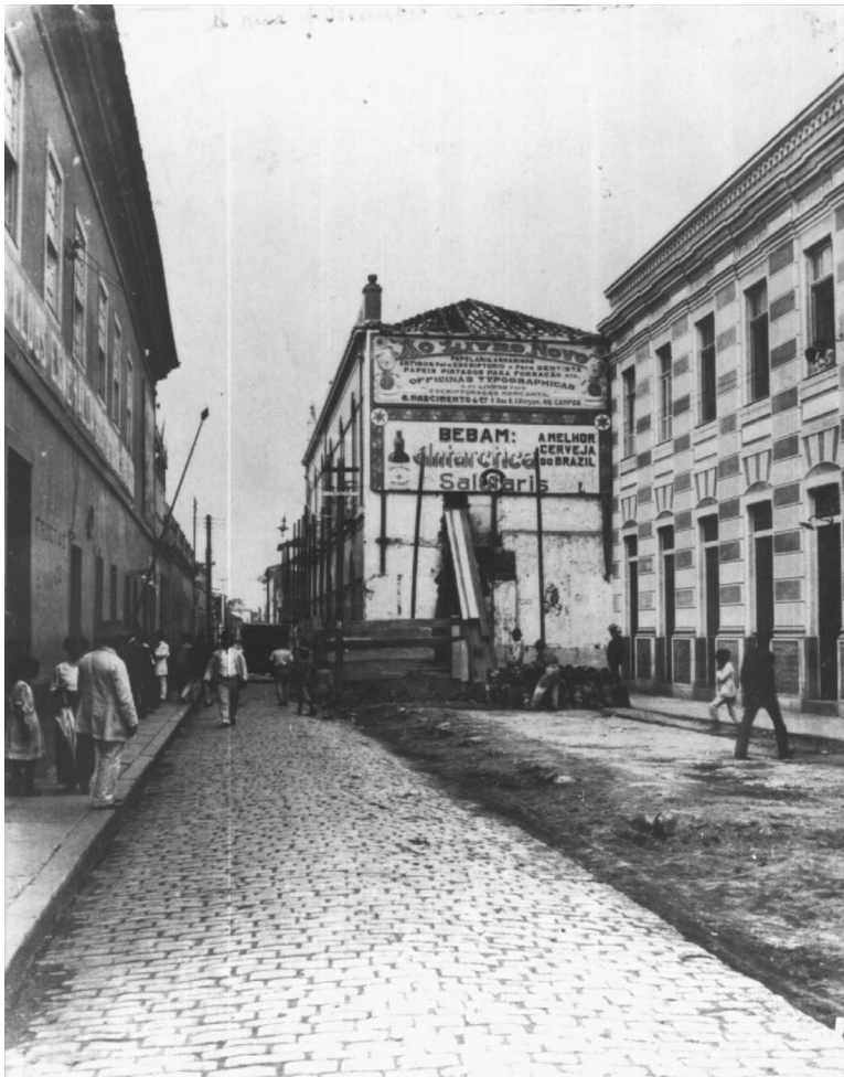
Figura 3 - Alargamento da Rua 7 de Setembro, em 1926
