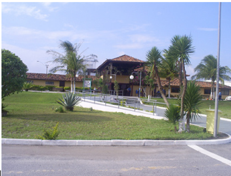
Figura 1 – Aeroporto de Cabo Frio Foto: Laila de Souza Gomes (2009)
