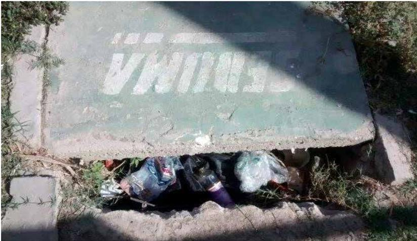
**Figura 8. Mecanismos de contenção entupidos**
