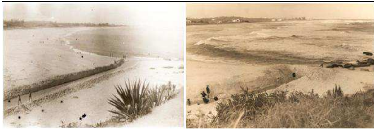
Figura 4. A Abertura da Barra era feita manualmente ou por máquina
