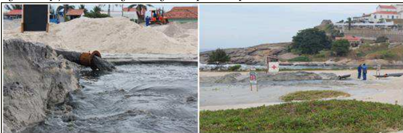
Figura 8. Despejo do resíduo dragado da Lagoa de Saquarema na praia de Itaúna
