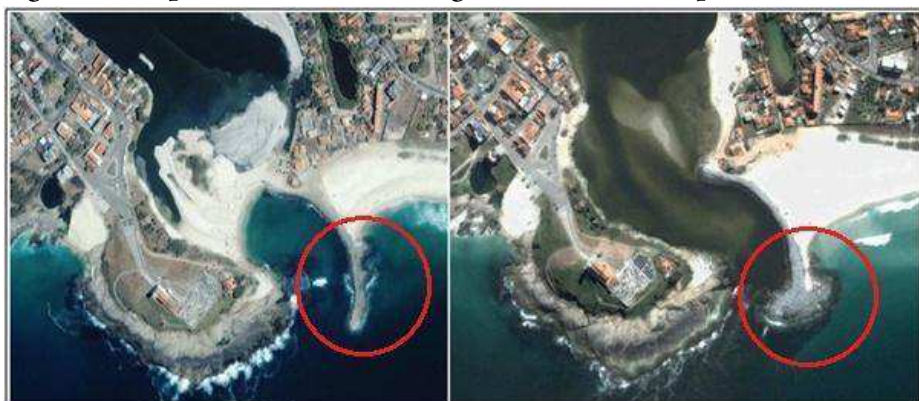
Figura 7. Colapso do enrocamento do guia-correntes de Saquarema, 2003 e 2005 respectivamente
