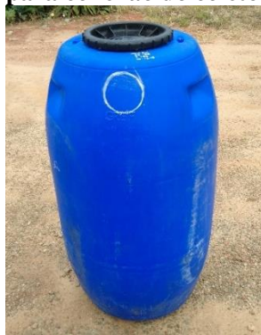
Figura 7. Círculo de 100 mm para conexão do coletor predial
