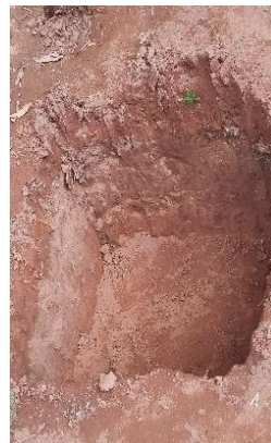
Figura 26. Trincheira para disposição e aterro de lodo seco
