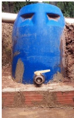
Figura 23. Dispositivo de descarga de lodo
