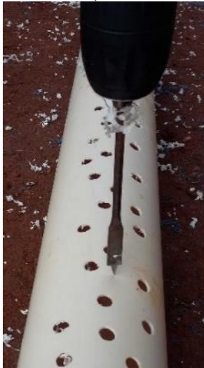
Figura 15. Confeção do tubo de drenagem com broca de 0,01 m
