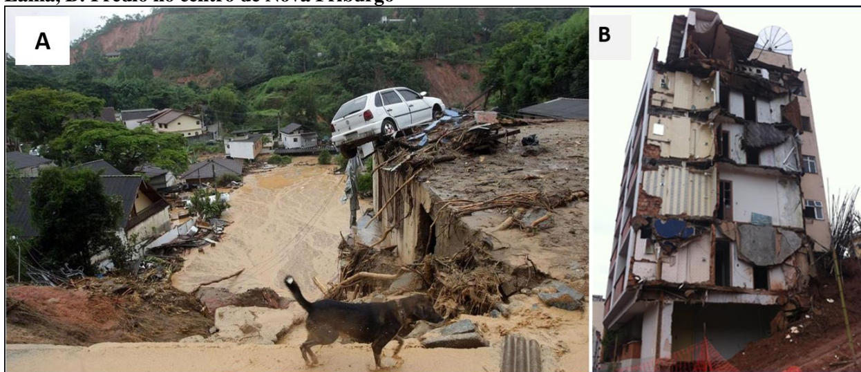
Figura 4. Áreas afetadas pelo desastre natural de 2011 em Nova Friburgo-RJ. A: Carro e Casas Tomados pela Lama, B: Prédio no centro de Nova Friburgo
