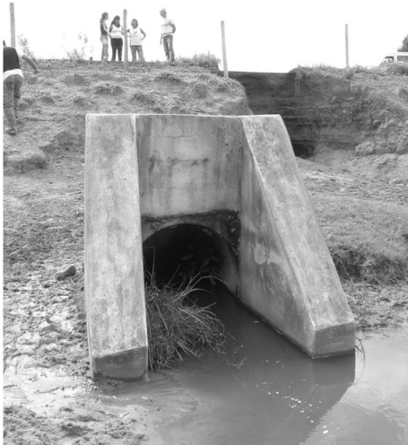
Manilha de escoamento das águas. RJ-196. São Francisco de Itabapoana
