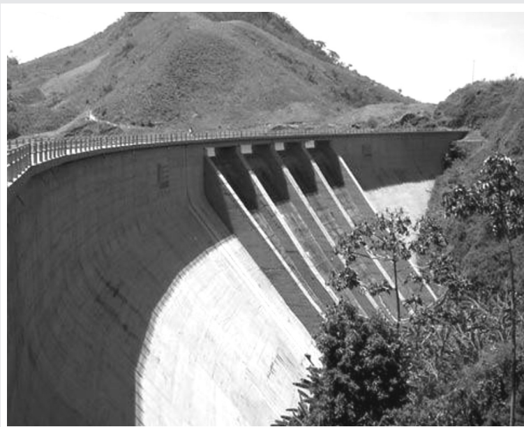
Barragem de Sodrelândia – RJ Foto: Phelipe Perboires.
