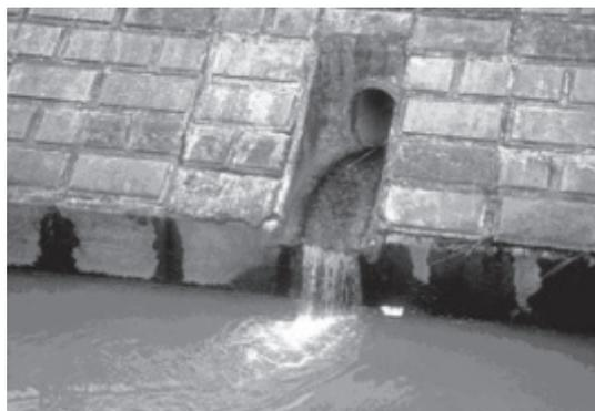
Figura 3: Despejo de águas pluviais e esgotos clandestinos
