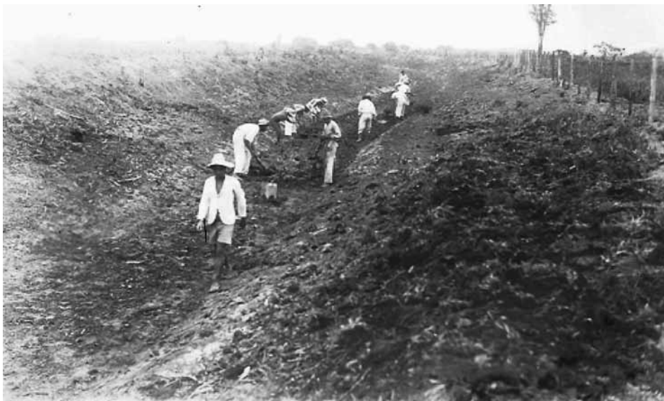
Figura 10: Aprofundamento do Canal do Nogueira na estaca 420 Fonte: Fotografia produzida pelo DNOS em 21/11/1939. Cedida por Arthur Soffiati.
