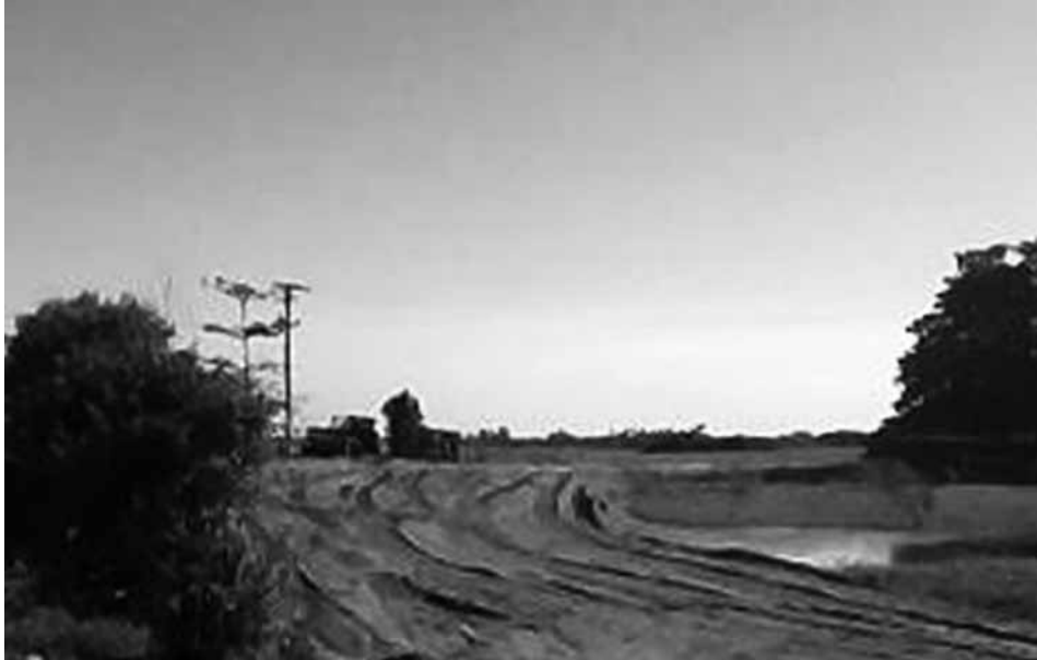
Figura 3 – Obstrução do canal do Brejo Comprido
