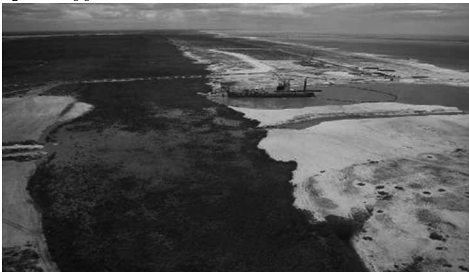
Figura 4 – Dragagem do canal de acesso ao terminal TX-2
