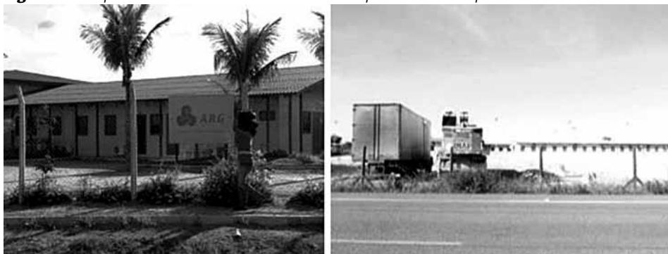
Figura 22. Empresas instaladas na RJ- 240 entre Campo da Praia e Amparo
