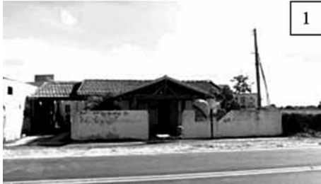
Figura 7. Exemplo de construção antiga da Praia do Açú
