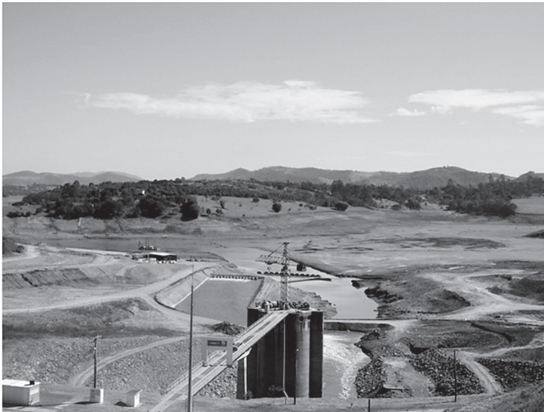
Figura 5 - Retirada de água do volume morto em represa do Sistema Cantareira em Joanópolis
