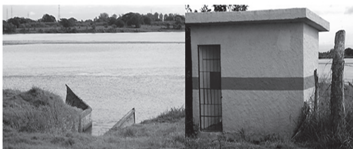
Figura 5 - Comporta do Canal São Bento
