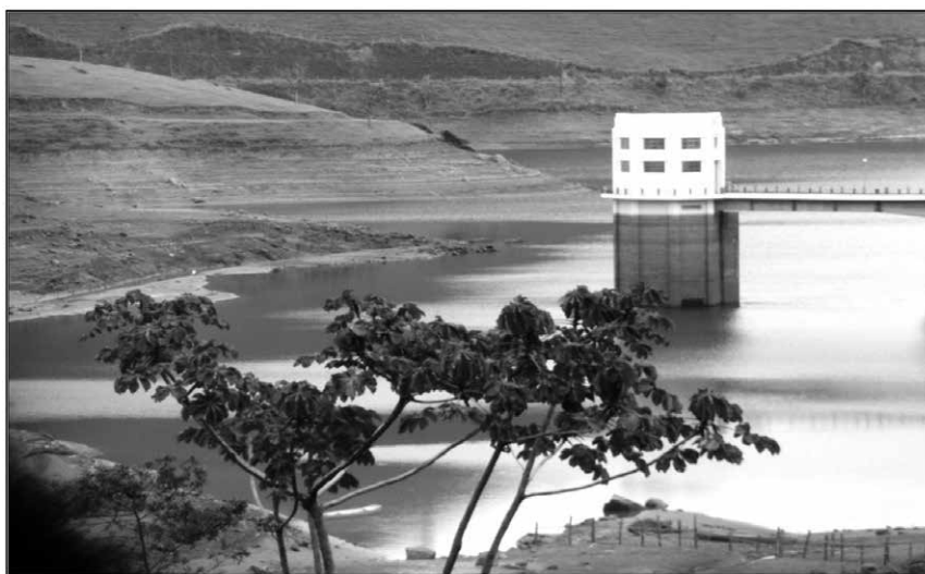
Figura 4: Centro do Reservatório da Represa do Macabu e Casa de Máquinas para Transposição das Águas
