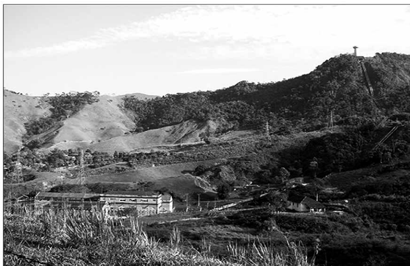
Figura 6: PCH Macabu e Tubulação em Queda de 336 m após transposição por túnel subterrâneo
