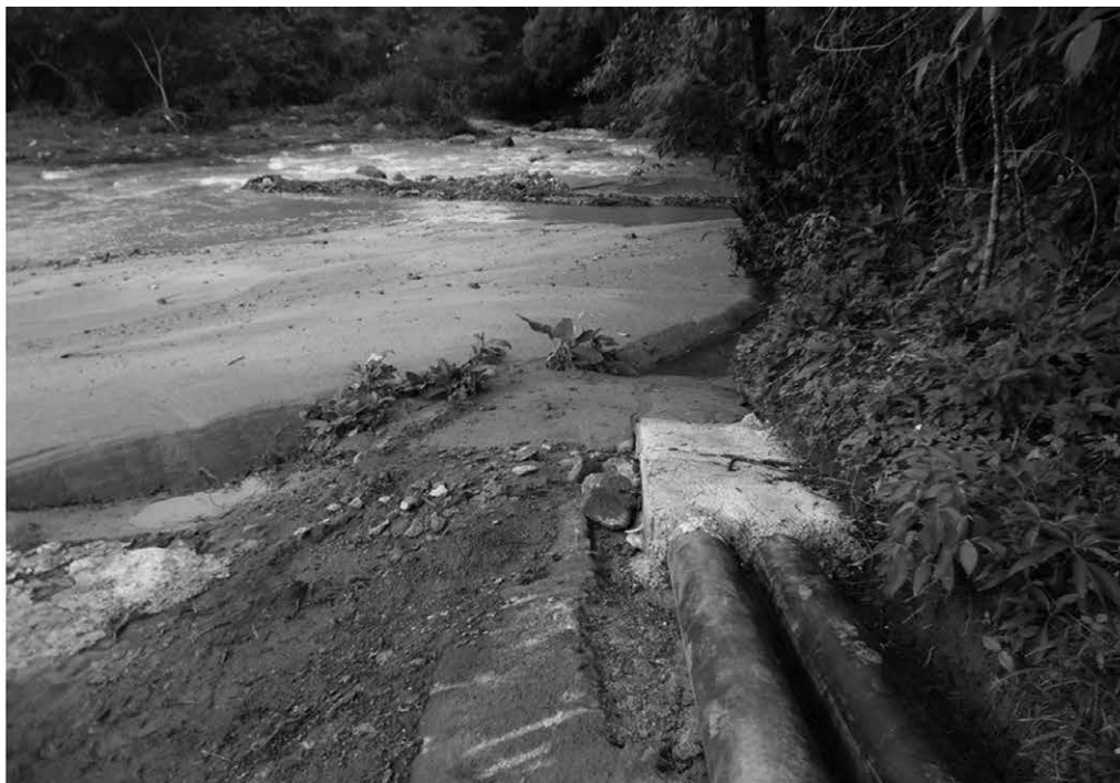
Figura 17: Local de captação de água para a população de Conceição de Macabu (problemas de sedimentação decorridos da erosão acelerada em áreas desmatadas geram transtornos para os serviços públicos)
