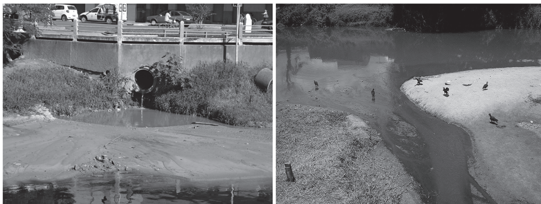
Figuras 4 e 5: Lançamento de esgoto in natura no rio Itabapoana
