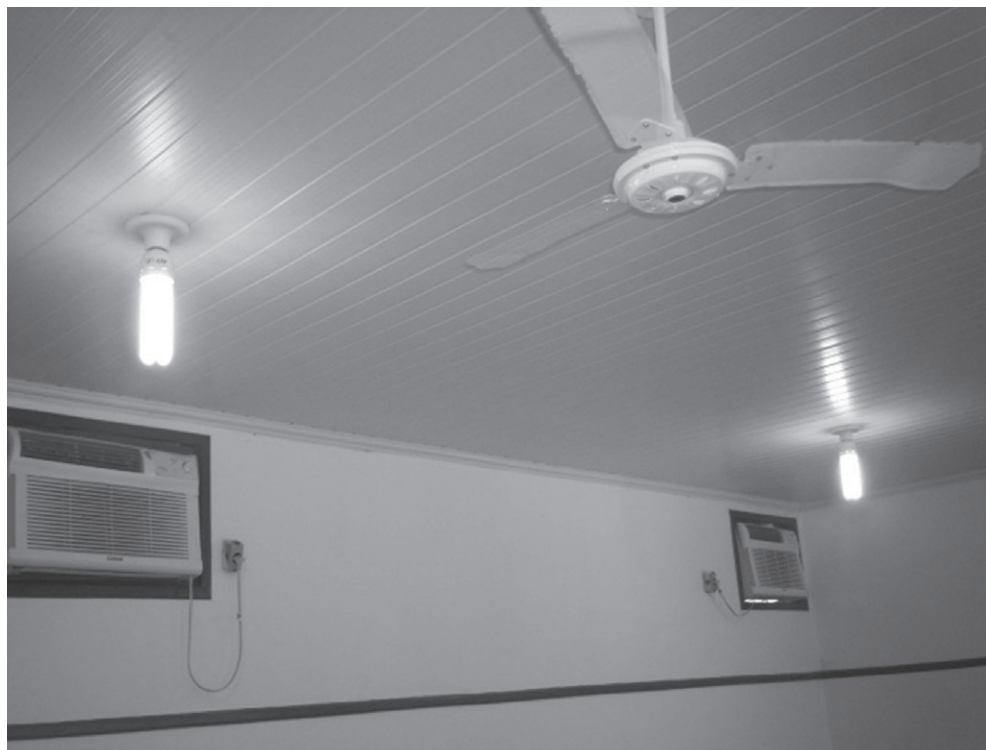
Foto 2 - Sala de aula não utilizada com ventilador e ar-condicionado ligados, e lâmpadas acesas – Escola F
