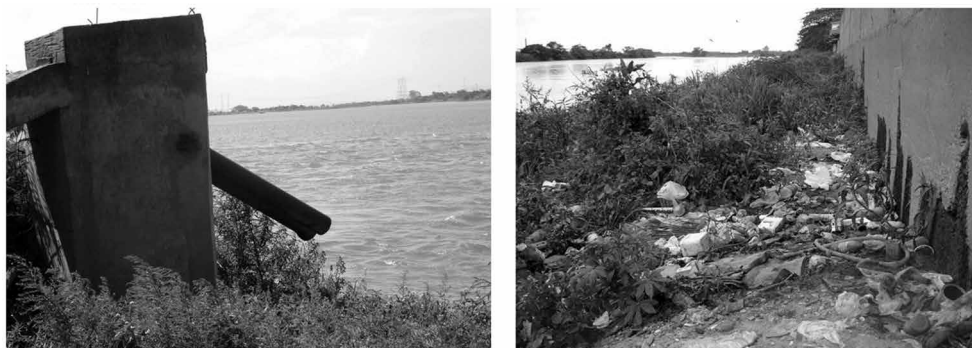
Figura 2 – Despejo de esgoto in natura e descarte de lixo nas margens do RPS na Ilha do Cunha e na Matadouro
