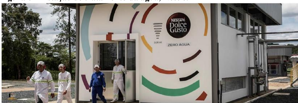
Figura 6 - Estação de tratamento da água, Nestlé.
