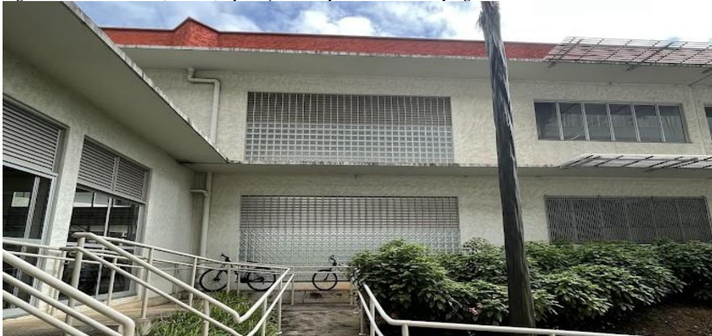
Figura 4. Blocos de vidro, beirais, e proteção solar por meio de brise pergolado na fachada Norte
