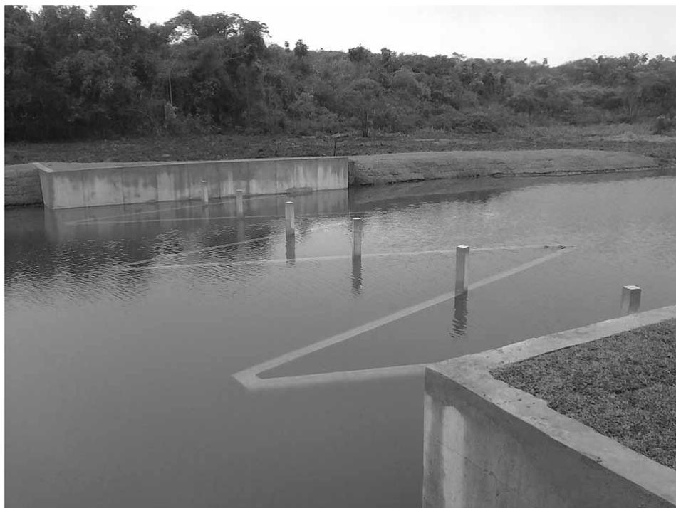
**Figura 3:** Vertedouro no canal extravasor da lagoa Imboacica
