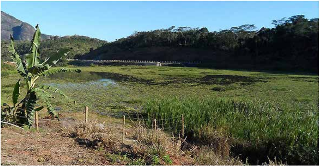
Figura 8: Presença de macrófitas no reservatório da PCH Pedra do Garrafão
