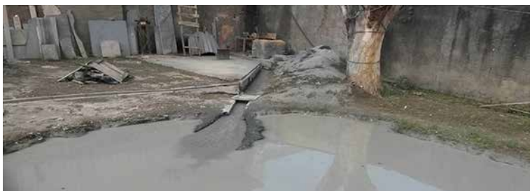
Figura 7 - Ponto 3: saída de água da serra maior e entrada no primeiro tanque de decantação
