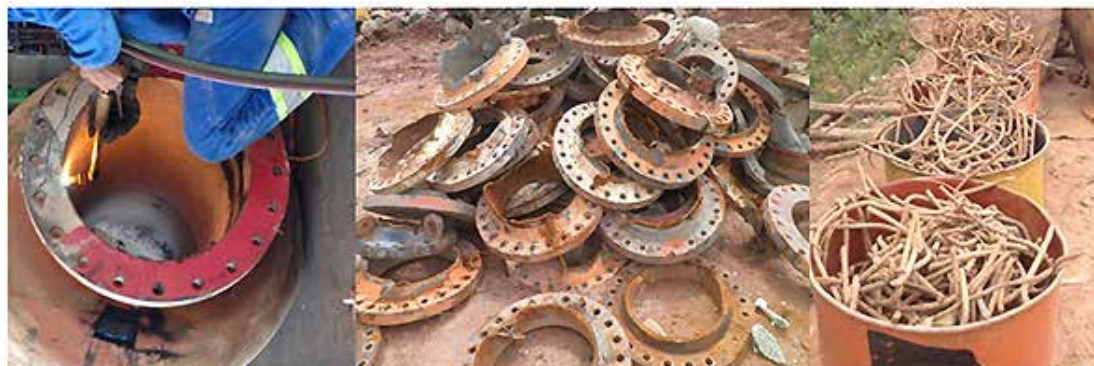
Figura 11: Separação dos flanges e materiais metálicos
