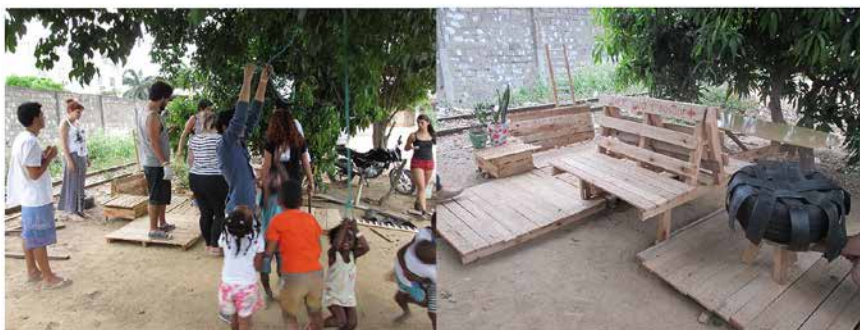
Figura 5. Espaço de convivência construído na Comunidade da Margem da Linha
