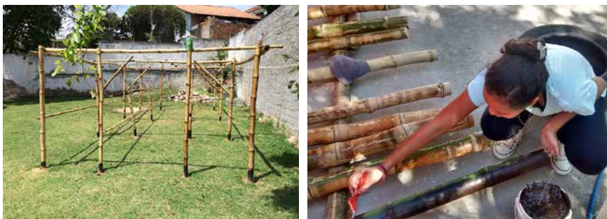
Figura 3. Estufa semipronta e o processo de impermeabilização das vigas (figura 3A à esquerda e figura 3B à direita)
