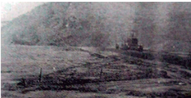
Ilustração 7 – Imagem na terraplanagem do terreno do que seria a Escola Técnica. Fonte: O Debate (1992).
