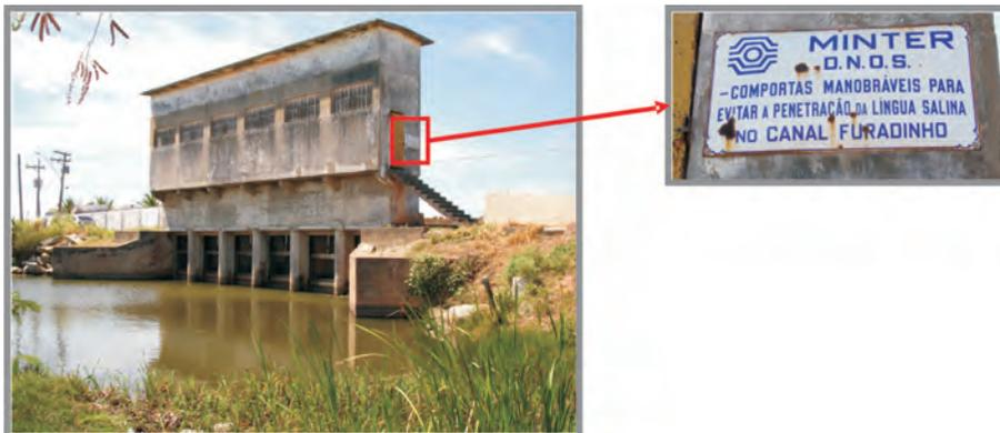
Figura 5.2 - Comportas de controle da entrada de água do mar nas terras baixas de Farol de São Tomé, no Canal Furadinho (Campos dos Goytacazes)
