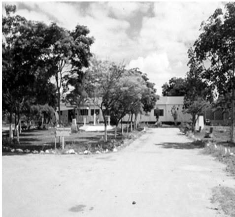
Foto 1: Sede administrativa da escola
