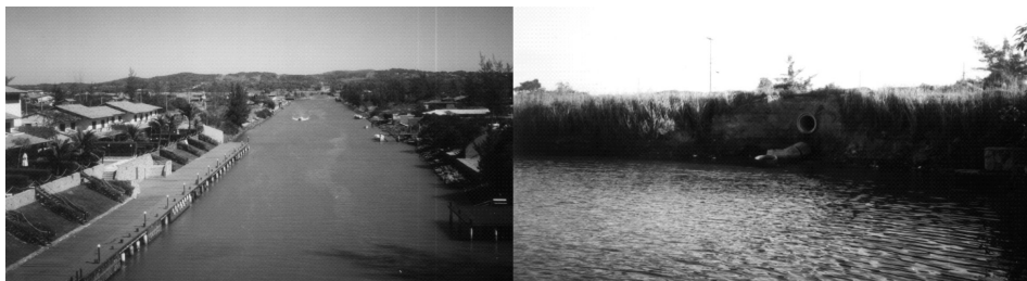
Figura 25: Rio Trapiche transformado em Marina (E). Bueiro para permitir o fluxo d'água do que restou do rio.
