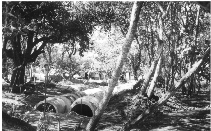
Figura 27: Manilhamento do curso final do Córrego de Barrinha, Praia de Manguinhos. Fonte: Foto do autor (2005)
