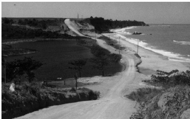
Figura 2: Barramento total da Lagoa de Caculucage pela rodovia ES-060, impossibilitando sua comunicação permanente ou periódica com o mar, um dos fatores que condenaram o manguezal antes existente nela ao desaparecimento.
