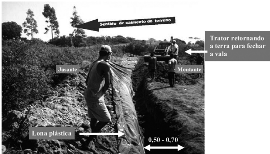
Figura 56: Procedimento de implantação de uma barragem subterrânea
