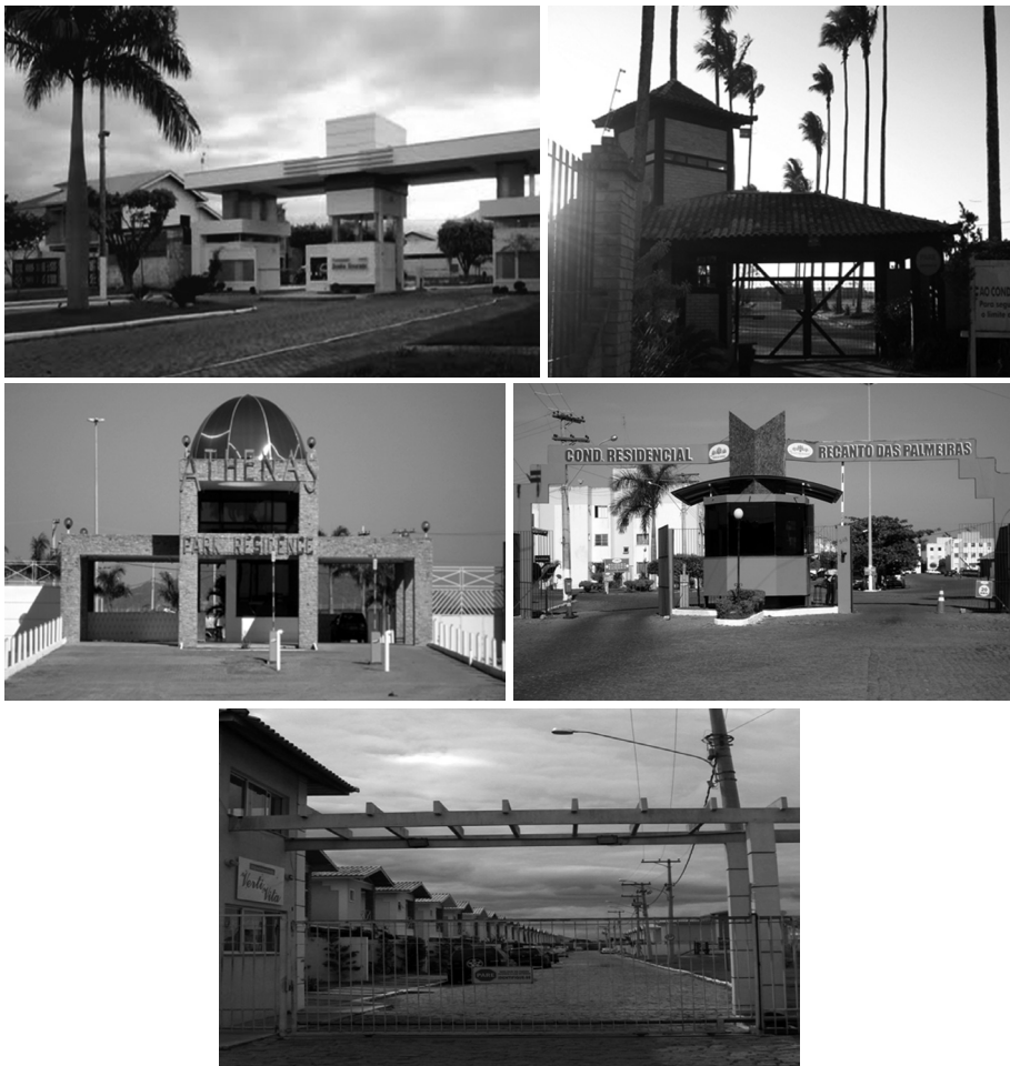
Figuras 20, 21, 22, 23 e 24 – Condomínios implantados nas proximidades da BR 101 em Campos dos Goytacazes (RJ): Sonho Dourado, Athenas, Nashville, Recanto das Palmeiras, Verti Vita
