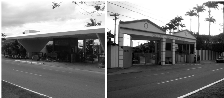
Figuras 7, 8, 9, 10 e 11 – Condomínios residenciais na Av. Alberto Lamego. Bougainvillée, Horto, Bosques das Acácias, Verdes Campos e Privilége
