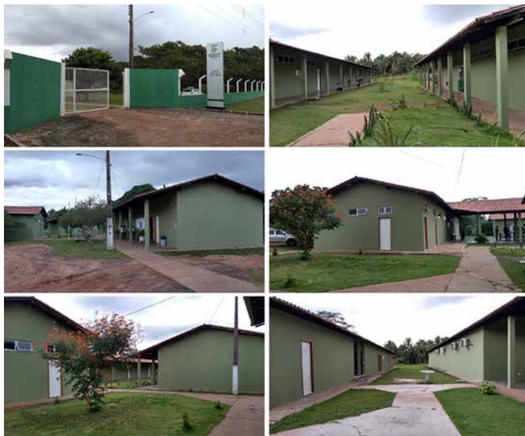
Figura 11. Nova estrutura do Campus Avançaço José de Freitas
