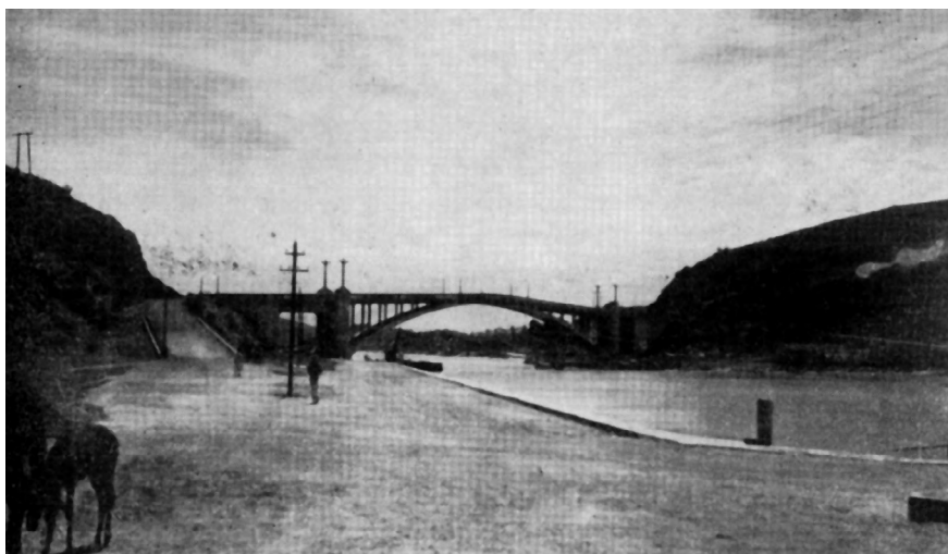
Fig nº 5 – Ponte Feliciano Sodré, sôbre o canal da lagoa de Araruama, próximo à sua barra e ao pôrto de Cabo Frio
