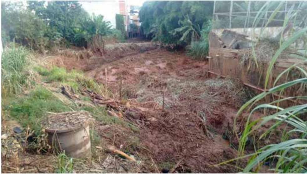
Figura 35 - Leito do córrego da Conceição após inundaç o sofrida. Centro, Viçosa, MG
