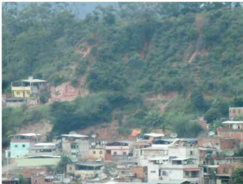
Figura 31 - Cicatrizes de escorregamento em encosta acima de áreas (de risco) ocupadas. Bairro Sagrada Família, Viçosa, MG
