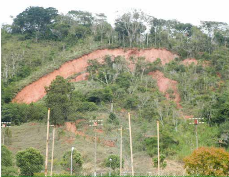
Figura 30 - Escorregamento rotacional ocorrido em área com cobertura vegetal. UFV, Viçosa-MG
