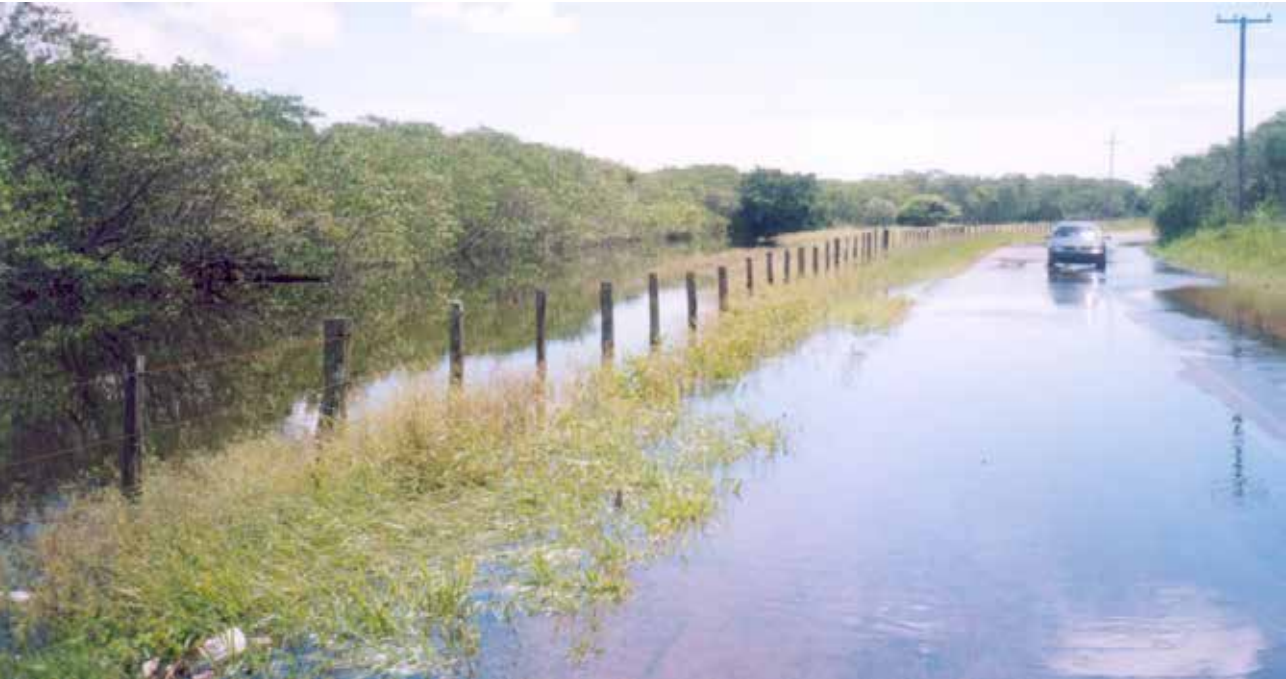
Figura 9 - Enchente do rio Guaxindiba em 2008-9, inundando a RJ-196
