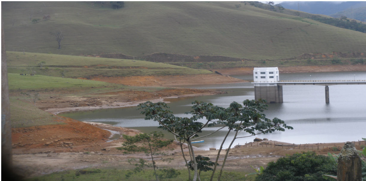
Figura 1 – Reservatório da Barragem do Macabu (Localidade de Tapera, Trajano de Morais-RJ);
