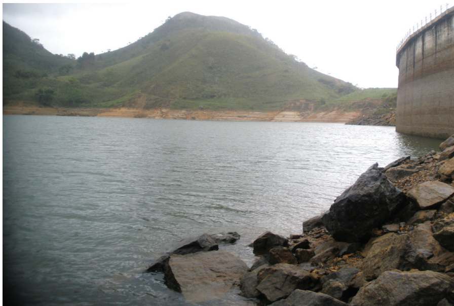
Figura 2 – Barragem do Macabu ( Próximo a Sodrelândia, Trajano de Morais-RJ) - Fonte: Produção Própria.
