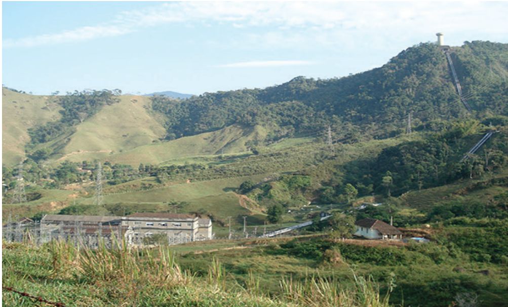
Figura 2 – PCH Macabu e Tubulação em Queda de 336m após transposição por túnel subterrâneo. Fonte: Quanta Geração S/A, 2012. Disponível em: www.quantageracao.com.br
