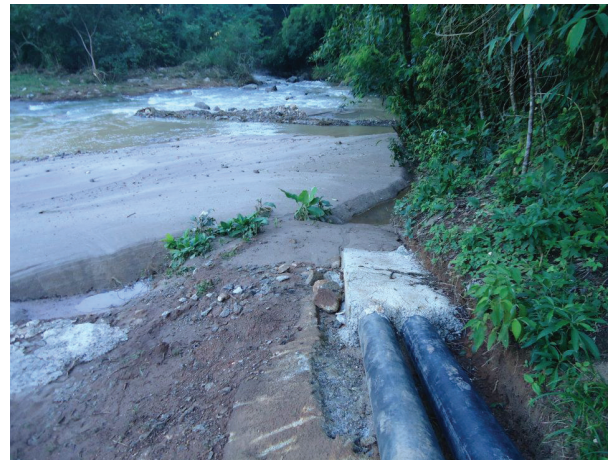
Figura 15: Local de captação de água para população de Conceição de Macabu (problemas de sedimentação decorridos da erosão acelerada em áreas desmatadas geram transtornos para os serviços públicos).
