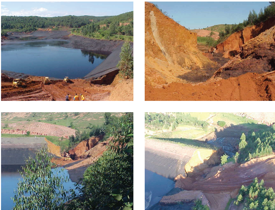
Figura 2 – Fotos do local onde se encontrava o reservatório de poluentes que rompeu
