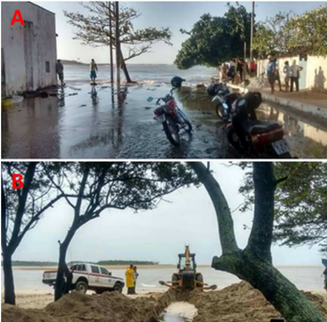
Figura 4. “Baixada” Rua do Frigorífico (A) / abertura de vala para escoamento sanitário (B)
